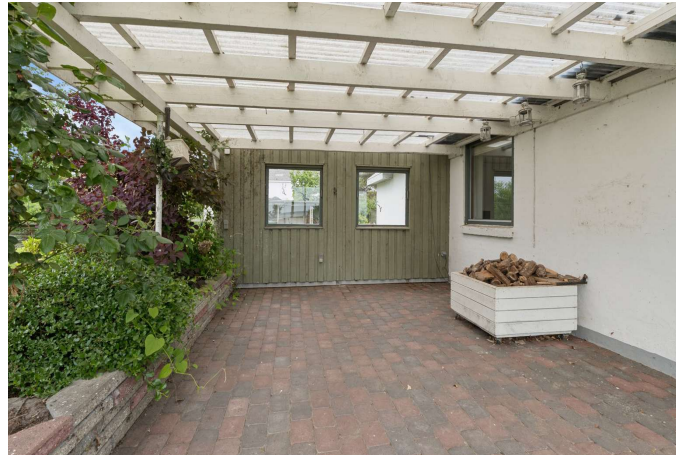
Skøn sydvendt overdækket terrasse
