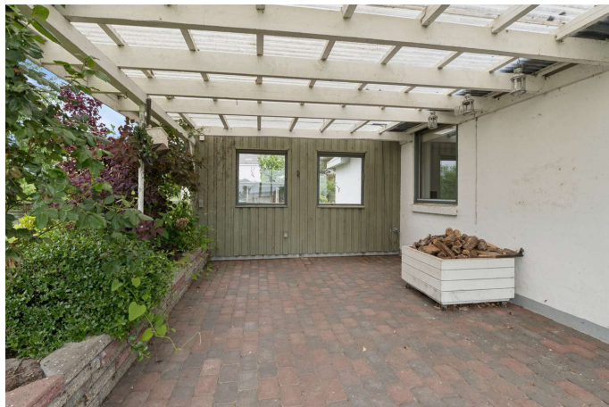
Skøn sydvendt overdækket terrasse
