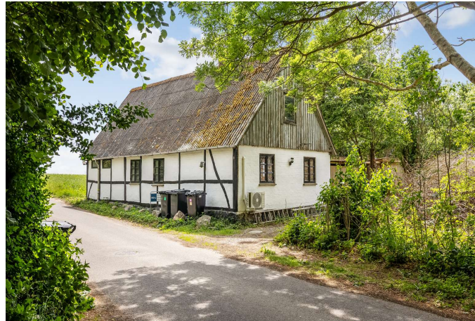
Malkevej nr. 6 - skal istandsættes
