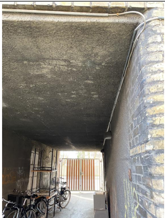
Portloft og vægge repareret med betoonprodukt
