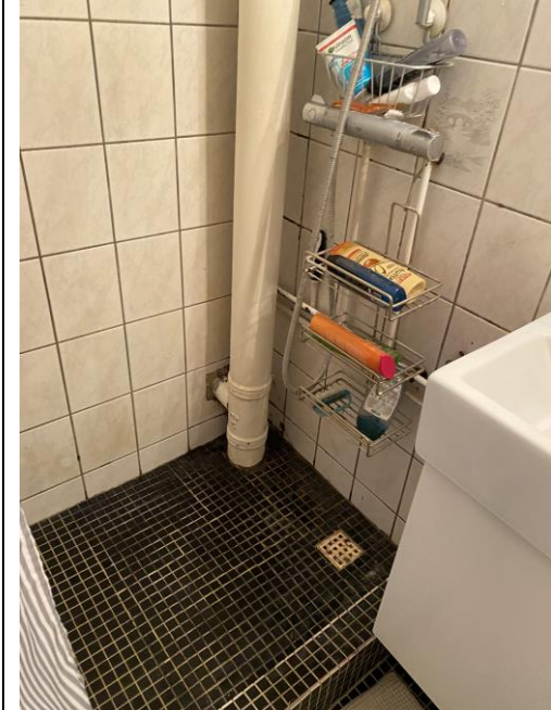
Faldstamme, SML/MA system uhensigtsmæssigt placeret i bruseområde
