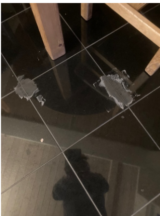
Stuen :4 reparationer af fuger i gulvet
