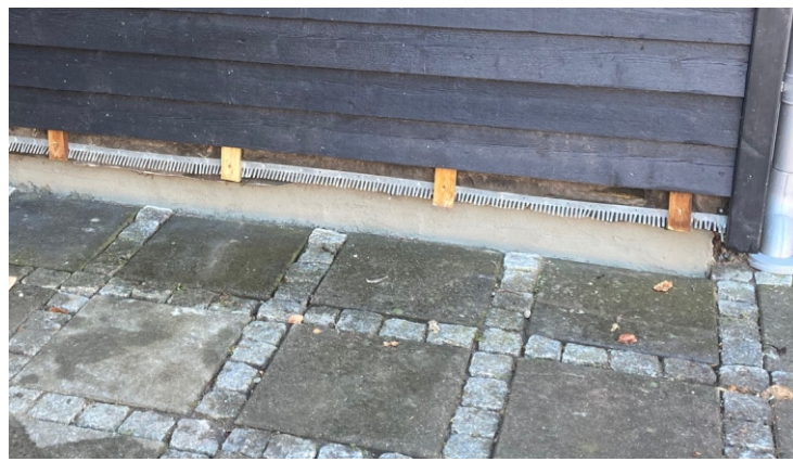
Gavl mod øst: Vindpap og musegitter rettet og soklen er pudset til H/V for indgang
