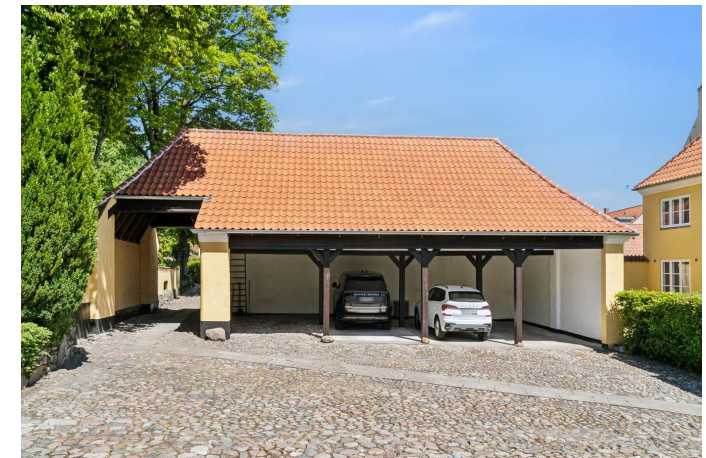
Garagebygning med plads til 4 biler.
