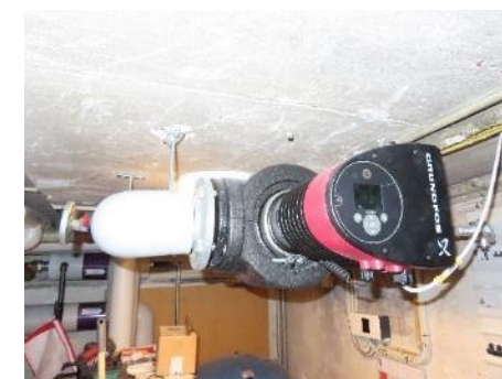
Cirkulationspumpe
