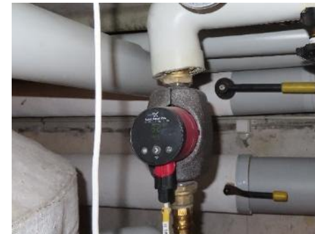
Cirkulationspumpe
