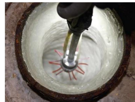
Eksempel på foring af faldstamme med "relining"
