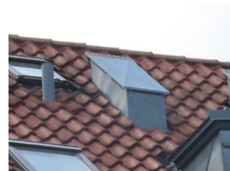
Ventilationshætte på tag
