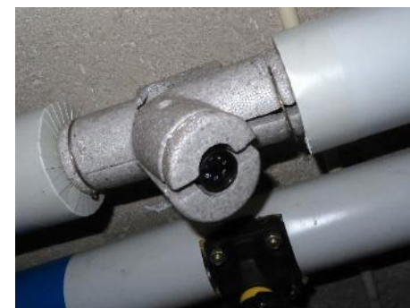
Termostatstyret cirkulationsventil
