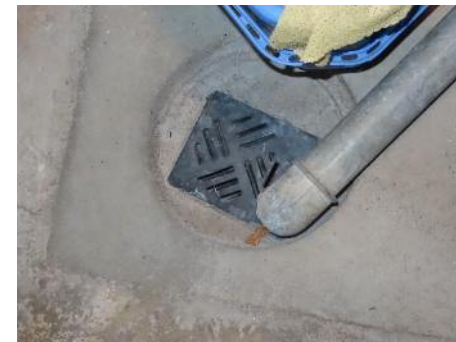
Gulvafløb i kælder
