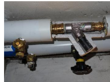
Termostatstyret cirkulationsventil
