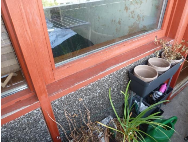
Malervedligehold er påkrævet. Der kan være behov for udlusninger, men generelt var træ hårdt og ok.
