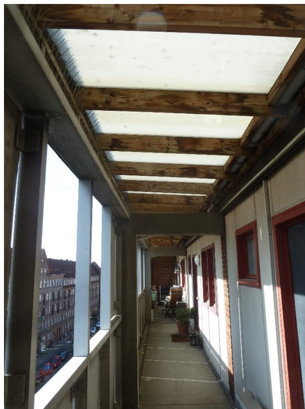
5. sal. Som øvrige. Dog er der her et halvtag af plast/akryl trapezplader på en træ-spær-konstruktion. Dette er defekt med mange huller. Træ mangler overfladebehandling. Her er tagrenden indbygget mod facaden til boligerne. Se under tag.
