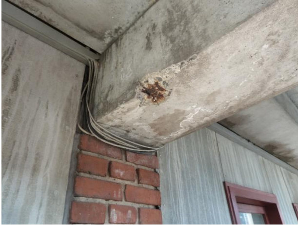
Beton er sprængt af her og rustent armeringsjern blotlagt. El-kabeltrukket hvor vand trænger ned.
