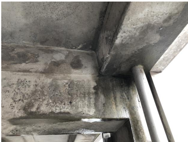
Altangang 3.sal Midtersøjle og bjælke er her markant opfugtede.
