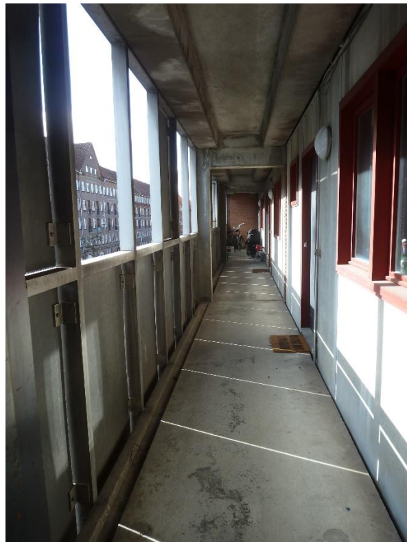
2. sal. Trappen i god stand. På altangangen ses en sprække mod facaden til boligerne hvor vandet løber ned, og giver løbestriber på facaden. Overfladevand løber også på undersiderne af betonelementerne.
