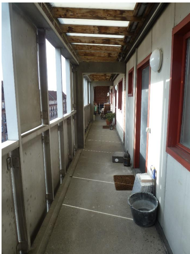
5. sal. Som øvrige. Dog er der her et halvtag af plast/akryl trapezplader på en træ-spær-konstruktion. Dette er defekt med mange huller. Træ mangler overfladebehandling. Her er tagrenden indbygget mod facaden til boligerne. Se under tag.
