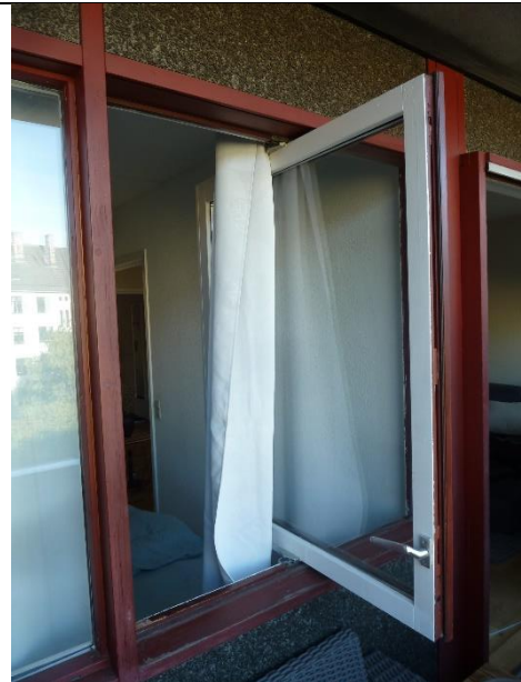
Drejevinduer i snedkerpartier i ok stand. Der mangler dog friskluftsventiler.
