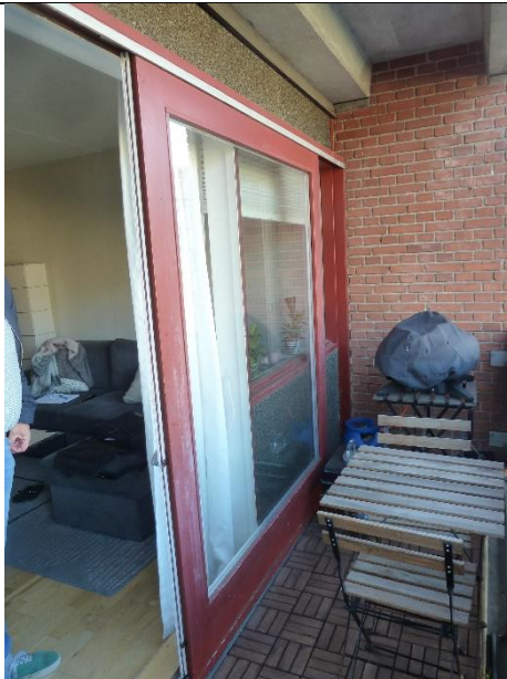
Skydedørspartier til altanerne mod gården. I ok stand skal dog eftergås og malerbehandles.
