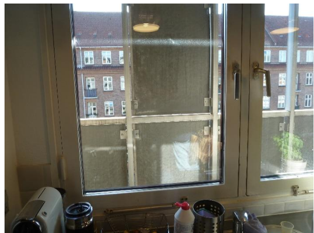
Køkken med emhættesug fra ventilator på tag. Ældre termoruder med kondens (punkterede) udskiftes løbende af foreningen.
