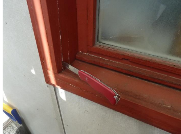
Malervedligehold er påkrævet. Der kan være behov for udlusninger, men generelt var træ hårdt og ok.
