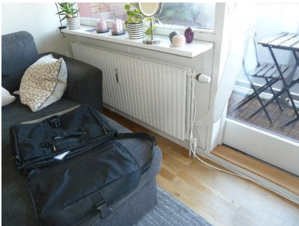
Inge bemærkninger generelt. Dog vil luftskifte ved en istandsættelse af vinduer og døre kunne forbedres med isætninger af friskluftventiler. Radiatorer i alle rum under vinduer. Brystningspartier er med for ringe isolering i forhold til nutidens krav.
