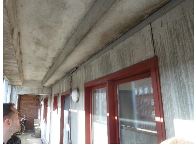
Beton er sprængt af her og rustent armeringsjern blotlagt. El-kabeltrukket hvor vand trænger ned.
