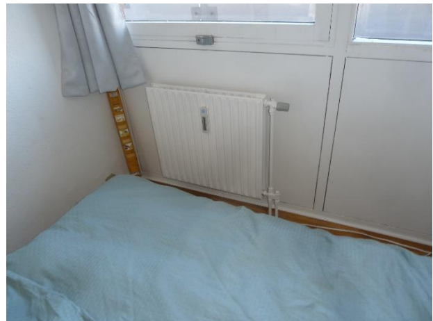
Inge bemærkninger generelt. Dog vil luftskifte ved en istandsættelse af vinduer og døre kunne forbedres med isætninger af friskluftventiler. Radiatorer i alle rum under vinduer. Brystningspartier er med for ringe isolering i forhold til nutidens krav.
