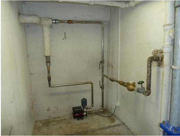
Hovedvandstik med nyere trykforøgeranlæg. 2222222222222222
