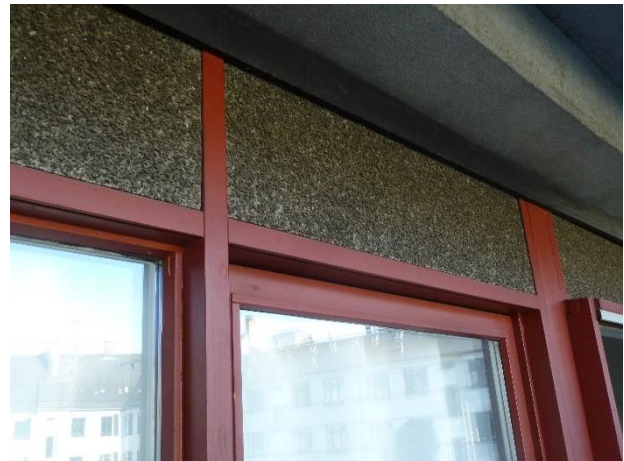
Drejevinduer i snedkerpartier i ok stand. Der mangler dog friskluftsventiler.
