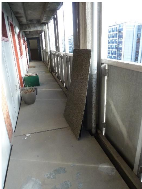
Her er en afmonteret facadeplade. Løbestrøber på eternitfacaden.
