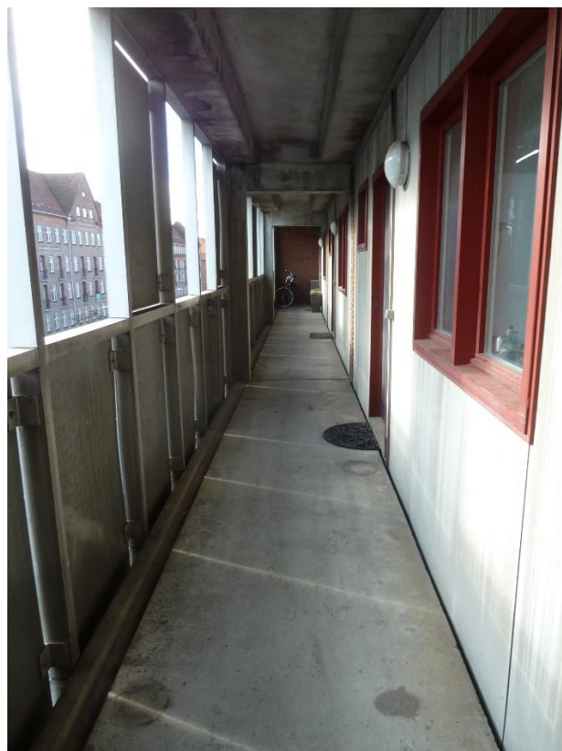
2. sal. Trappen i god stand. På altangangen ses en sprække mod facaden til boligerne hvor vandet løber ned, og giver løbestriber på facaden. Overfladevand løber også på undersiderne af betonelementerne.
