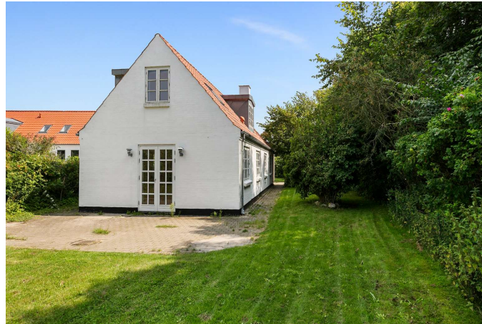
Huset set fra haven
