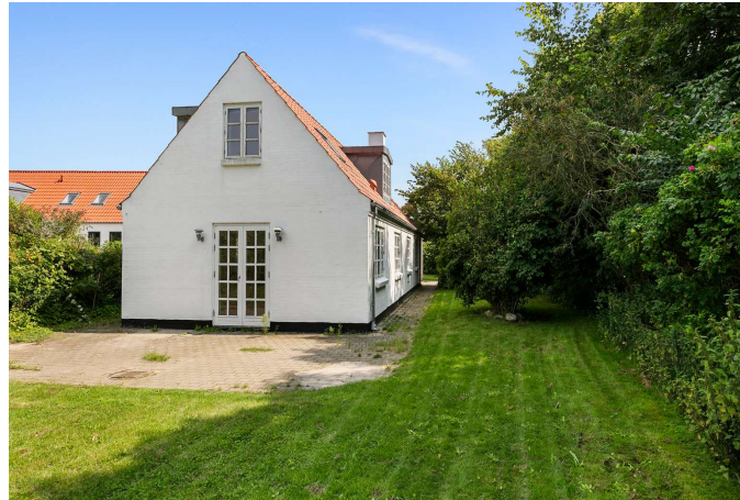
Huset set fra haven
