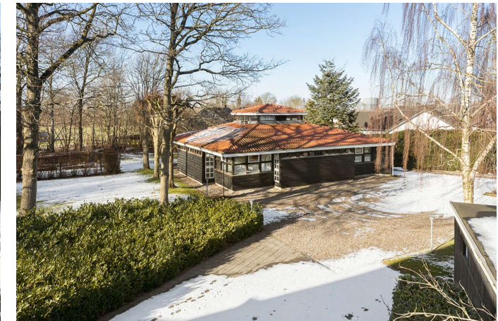
Parkeringsplads ved lægehuset
