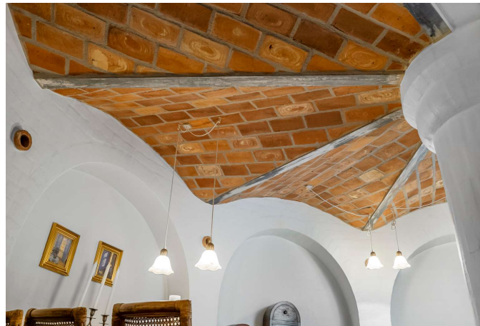
Hvælvede lofter i vinkælder
