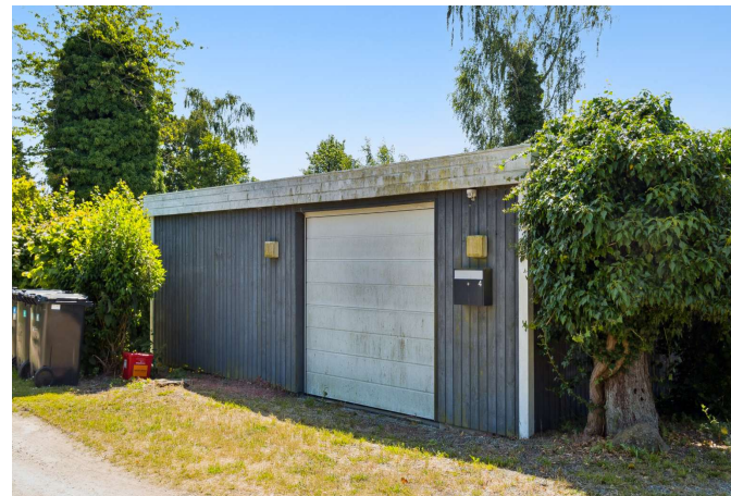
Stor garage og udhus
