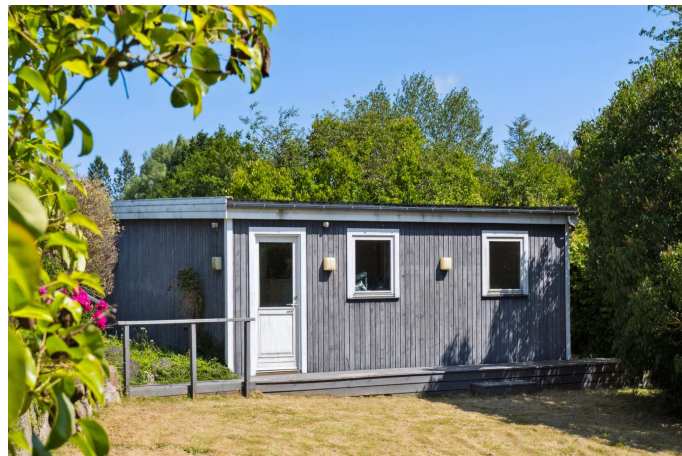
Stor garage og udhus
