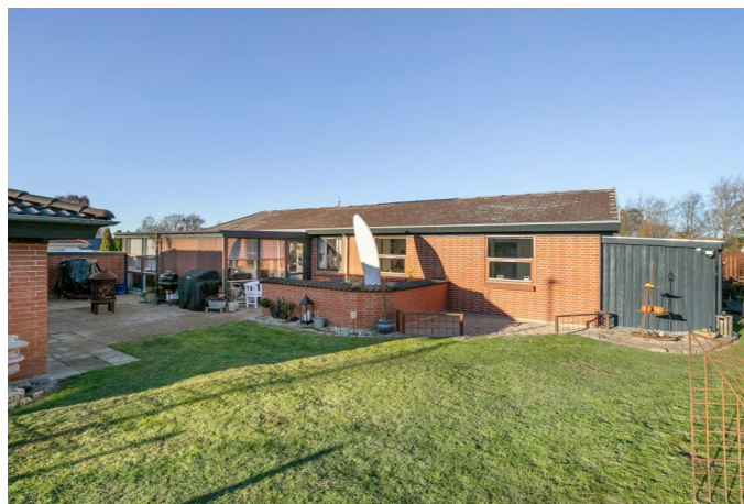
Huset set fra haven
