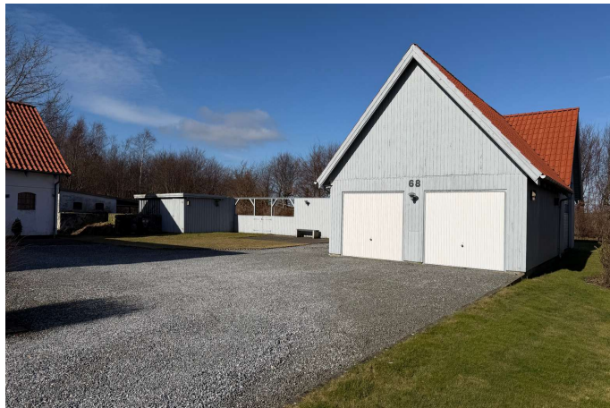
Garageanlæg Ialt 4 portadgange
