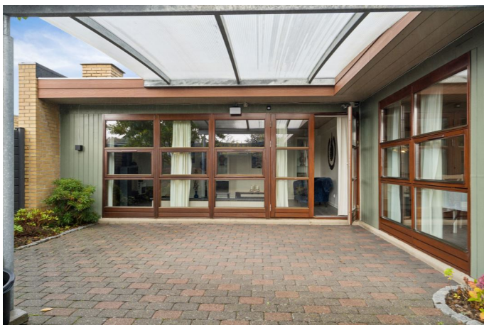
Overdækket terrasse ifm. alrum og opholdsstue
