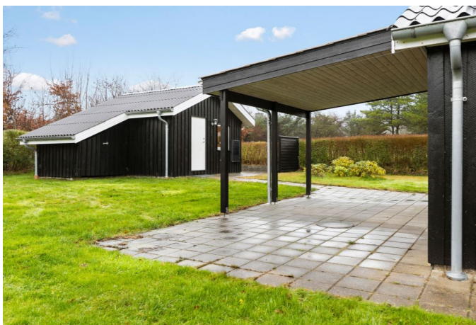
Overdækket terrasse og anneks med opbevaringskur
