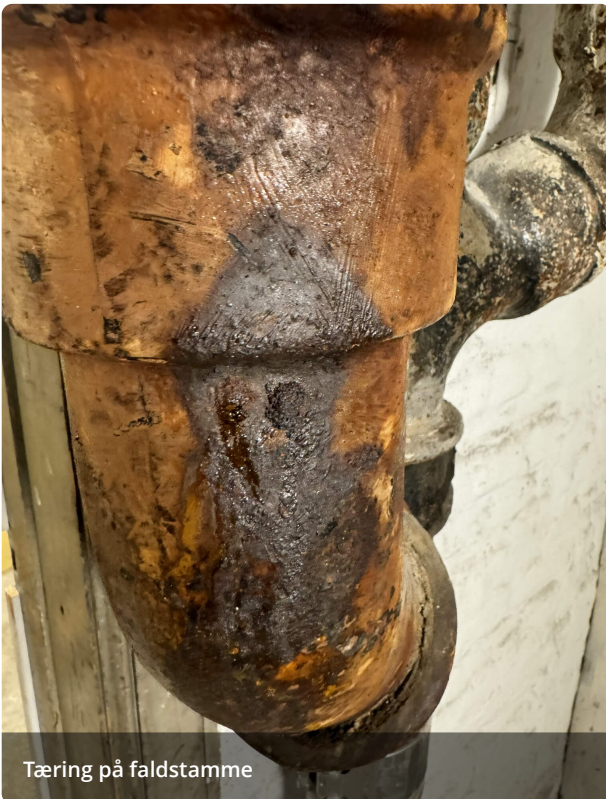
Nyt koblet på gammelt afløb
