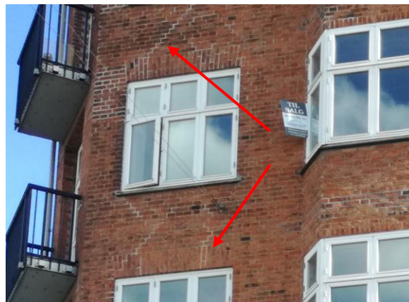
Udbedret sætningsskader
