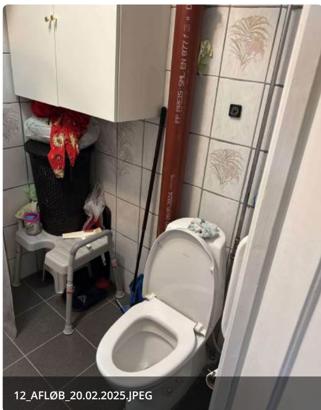
Nye afløb i bad
