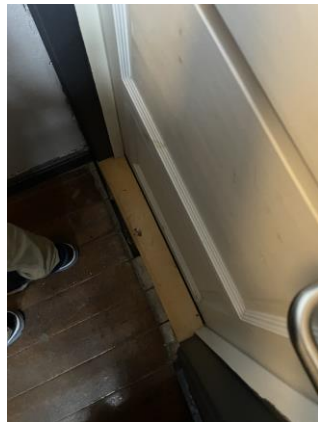
Foto 10 - mindre heldig samling mellem dørkarm og gulv (bitrappel).
