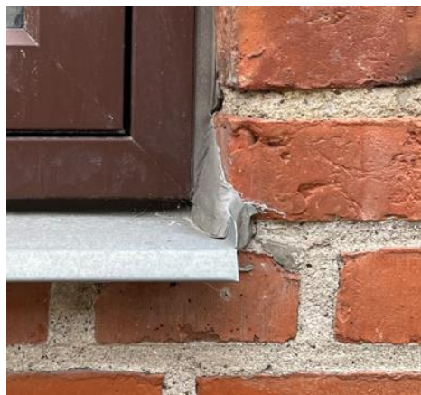
Foto 3 – samling mellem sålbænk og mursten løst med gummifuge.
