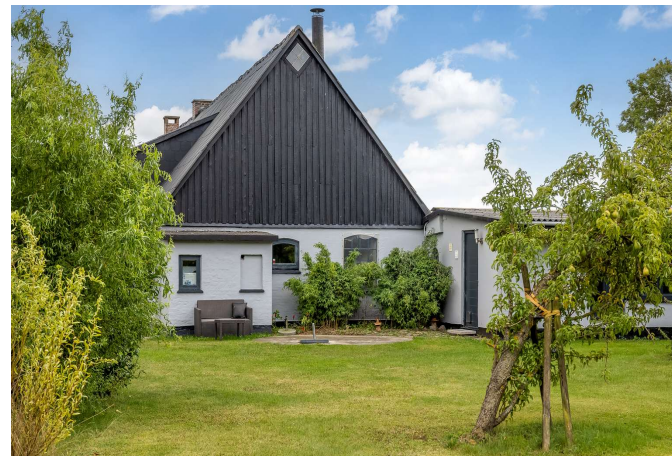
Lejlighed 2 i forlængelse af hovedhuset
