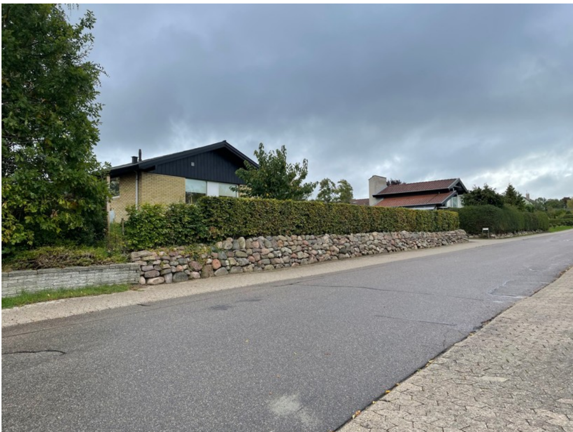
Eksempel på en støttemur af marksten, hvilket betragtes som et fast hegn. Hækken er til gengæld et levende hegn.
