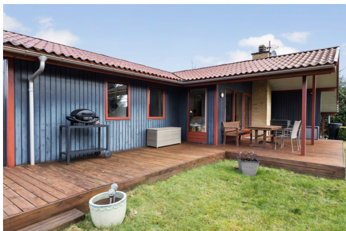
Træterrasse med overdækning
