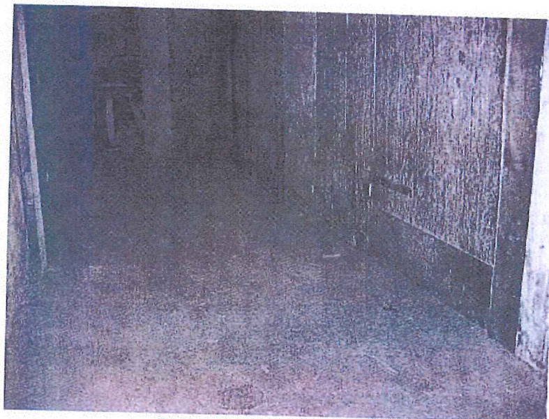
Pulterrumsvægge i kælder
