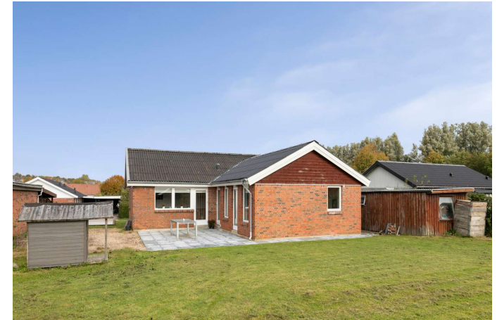
Huset set fra haven
