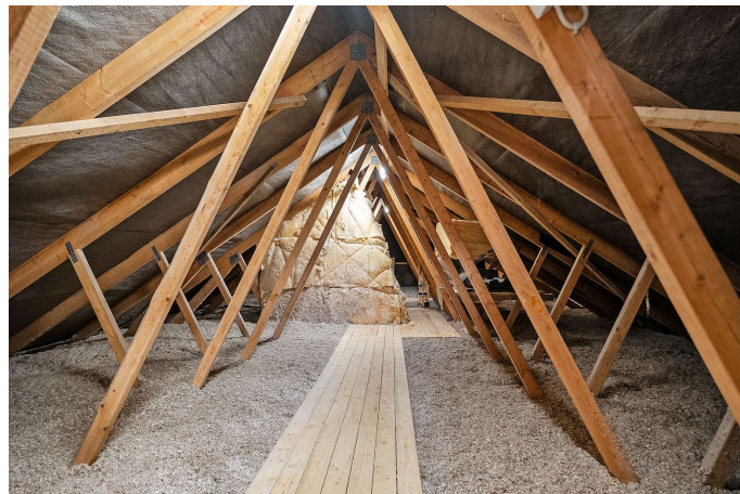
Loftrum - Isolering 400 mm.
