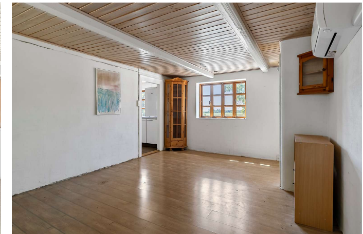
Stue med varmepumpe
