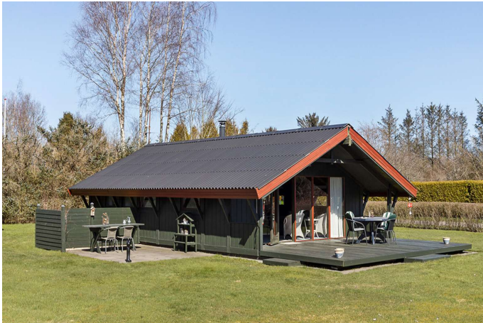
Facaden af sommerhuset set fra haven
