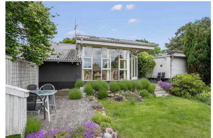
Huset set fra haven
