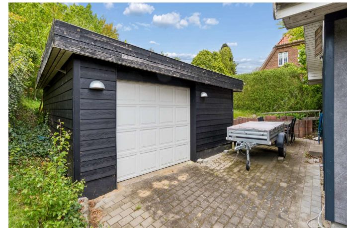
Garage med el-port.
