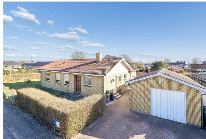
Facade af ejendommen
