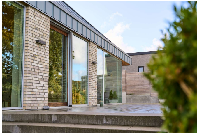
Store vinduespartier mod haven - udsigt til Engarealer
