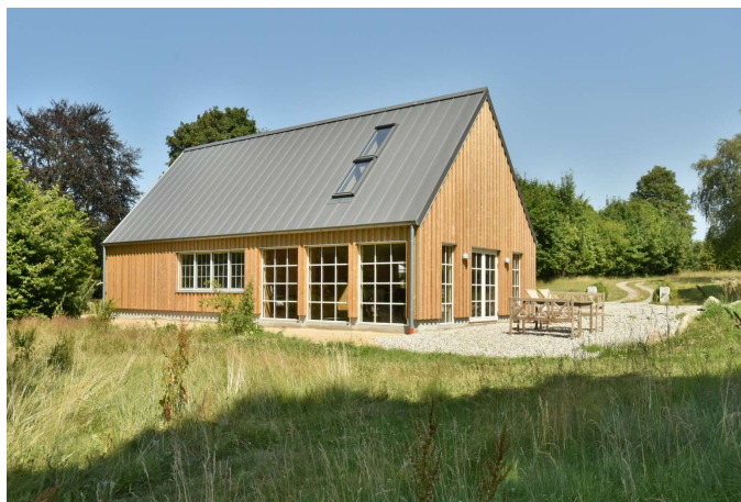
Ny bygning med orangeri, garage og værksted
