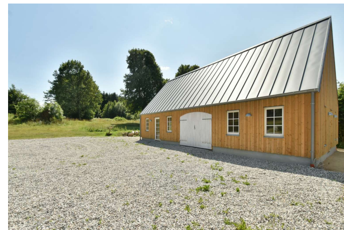
Ny bygning med orangeri, garage og værksted
