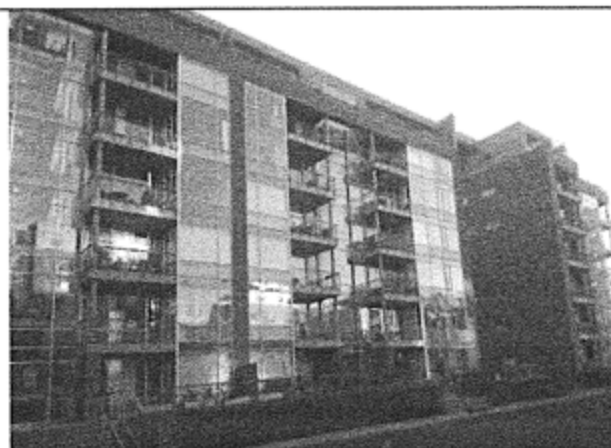
Facade fra gårdsiden med glasfelter imellem lejlighederne
