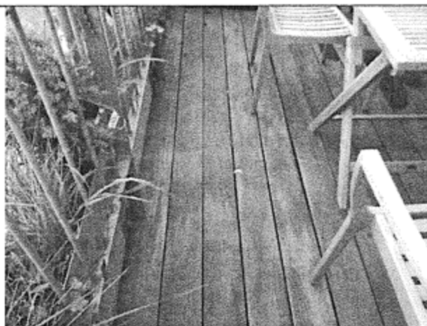
Terrassebrædder udlagt oven på tagpapdæk
