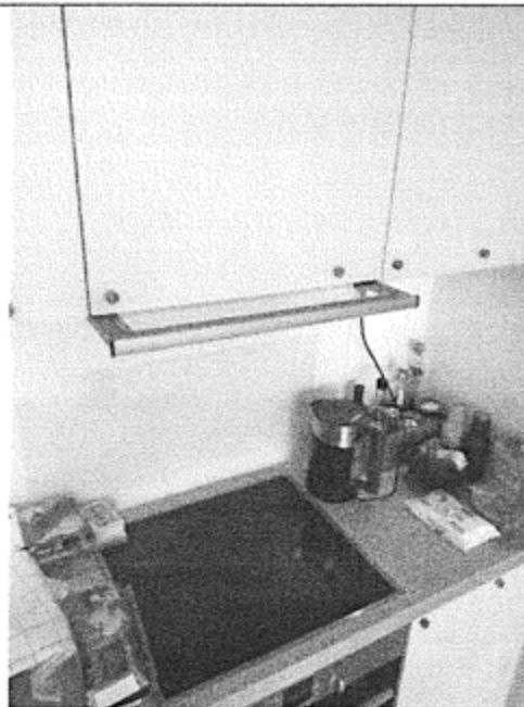
Ventilation i køkken
