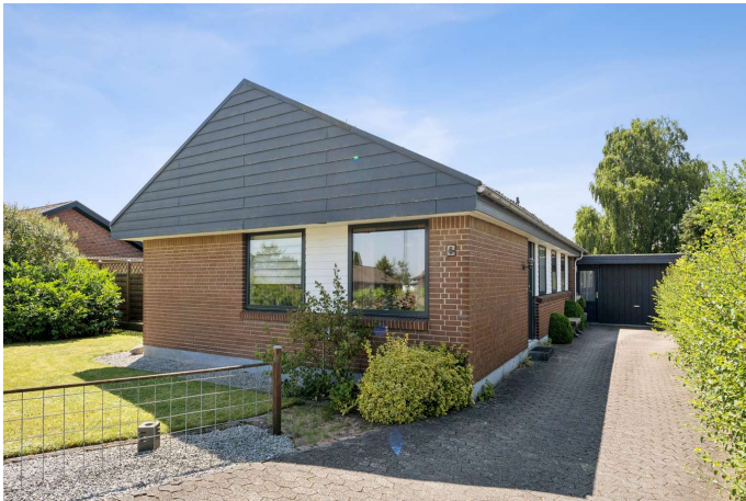
Flisebelagt indkørsel til garage.
