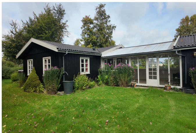
Ugenert gårdhave med indgang til overdækket terrasse
