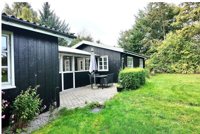
Facade mod nord. Lille terrasse.
